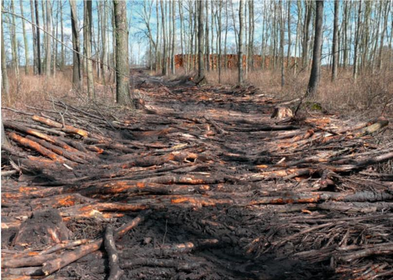
**Foto 16:** Knüppeldämme aus Durchforstungsholz können in einigen Fällen zumindest für kurze Strecken genutzt werden, um eine Befahrung mit Forstmaschinen zu ermöglichen.
